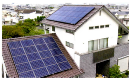
■ 9.42kWシステム (兵庫県)
