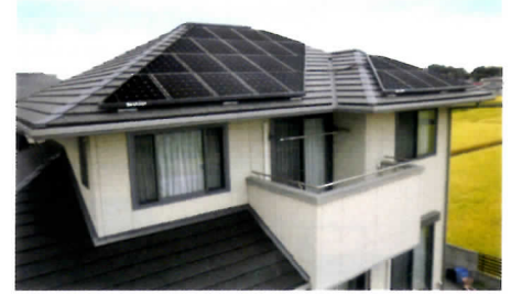
■ 4.95kWシステム (兵庫県)
