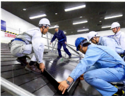
3日間の実技演習で、屋根置型モジュールの施工技術の完全マスターを目指した施工研修。
